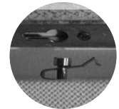
Der Noppen wird in der Deckenschiene verankert.
